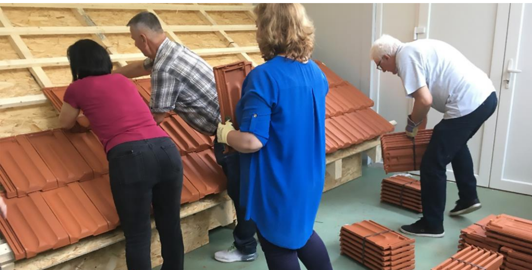
Dachmodell: Nach der Verlattung folgt das Decken mit Tonziegeln
